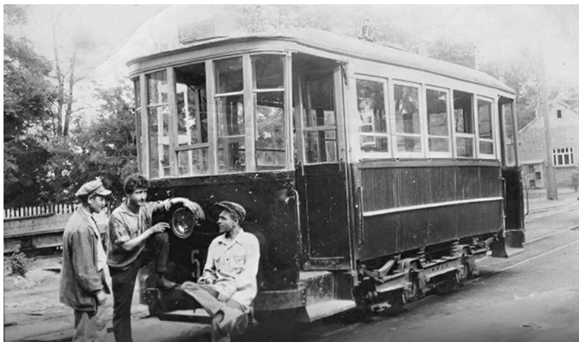
Старый двухосный моторный бельгийский вагон 1904 года поставки, модернизированный силами депо в 1920-х годах
